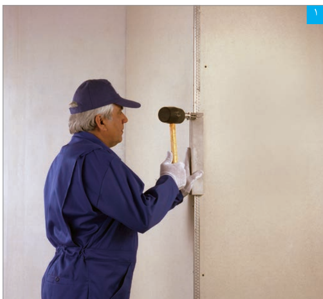
نصب سازه محافظ گوشه با دستگاه کرنربید کوب
