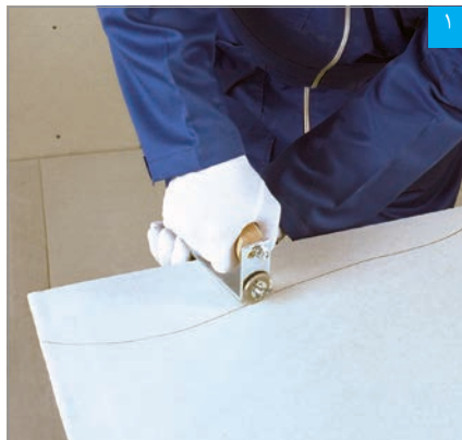
اجرای برش موج‌دار با دستگاه برش قرقه‌ای
