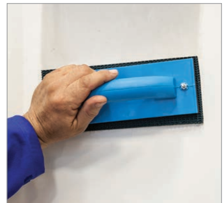
مرطوب کردن سطح دیوار با اسفنج نمدار
