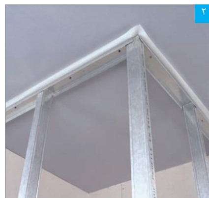
شکستن نوار چسب جداکننده پس از نصب سازه‌ها
