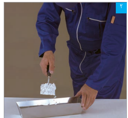
ریختن پودر بتونه در آب
