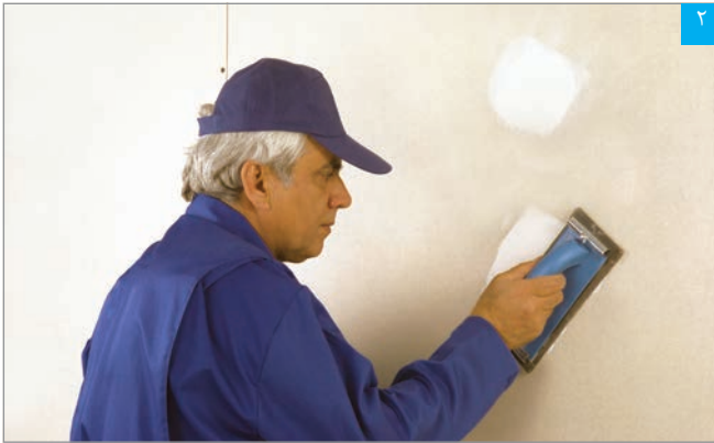
پرداخت سطح بتونه خشک
