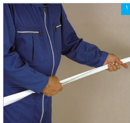
خم کردن نوار درزگیر با دست
