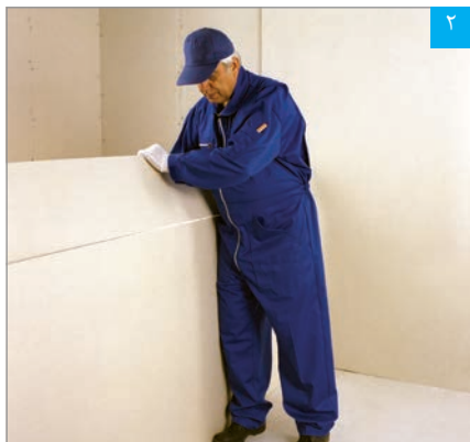
شکستن پنل در محل برش
