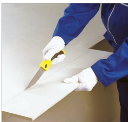
برش پنل با اره دستی
