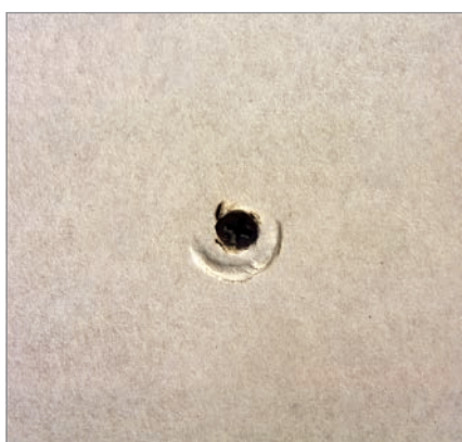
پیچی که به صورت مایل اجرا شده و به کاغذ روکش پنل آسیب رسانده است
