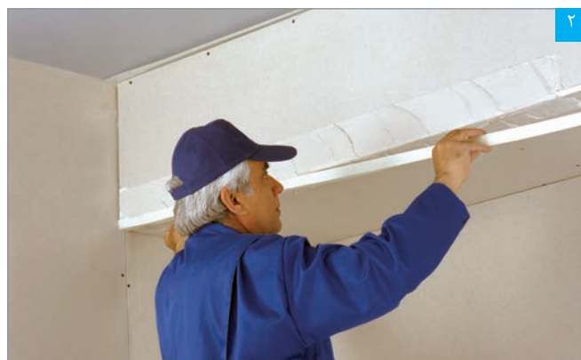
قرار دادن نوار درزگیر بر روی بتونه
