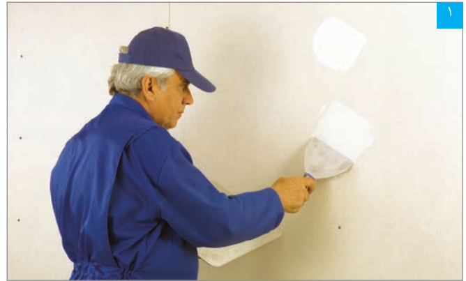
اجرای بتونه در محل پیچ‌ها
