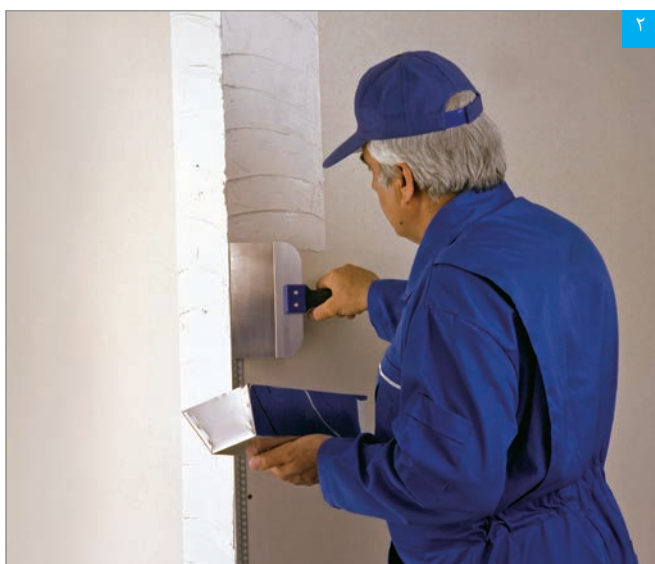
اجرای بتونه روی سازه محافظ گوشه
