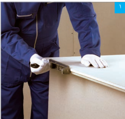
پرداخت لبه برش‌خورده با رنده
