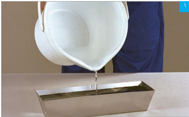
ریختن آب در ظرف تهیه بتونه
