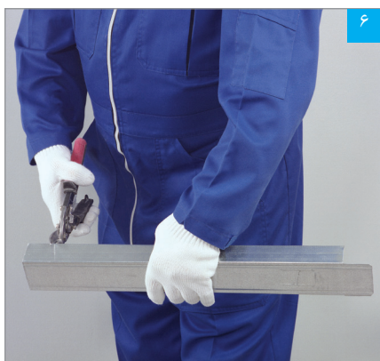
برش سازه پشت بند درز (به صورت زیانه)
