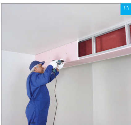
۱۱ اجرای پنل جانبی
