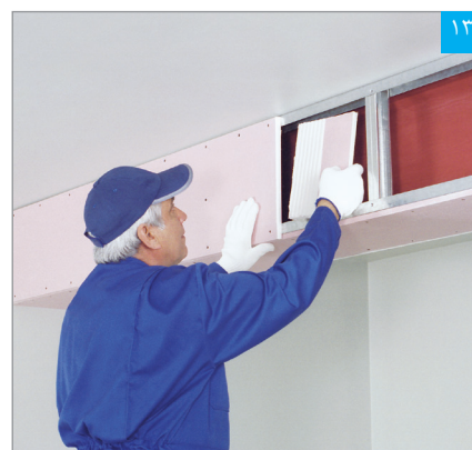
استقرار پنل پشت بند درز
