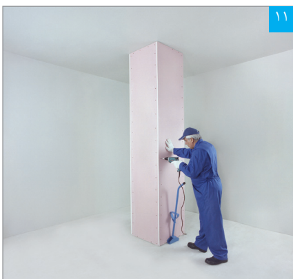
تکمیل پوشش کاری لایه دوم
