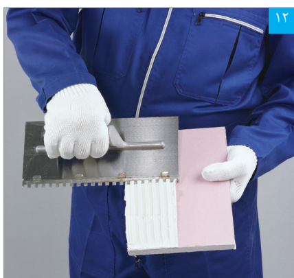
۱۲ اجرای بتونه درزگیر بر روی نیمی از پنل پشت بند درز (با استفاده از مالیه دندانه‌دار)
